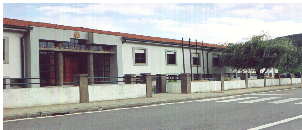
Fig. 3 – Santa Casa da Misericórdia de Mesão Frio
